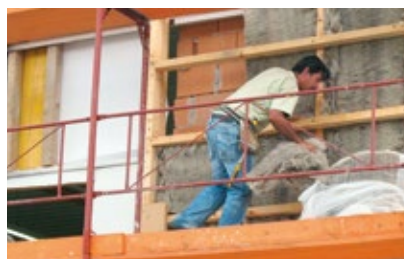
Ergee-Halle: Aufbringung der Schafwolle
